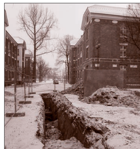
Snímek Sirotcí ulice je důkazem toho, že v lednu zde byla zahájena rekonstrukce kanalizace, i toho, že sníh padal i během letošní teplotně nadprůměrné zimy.
